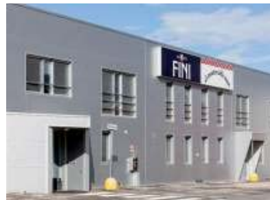
Il nuovo stabilimento di Ravarino (Mo)
